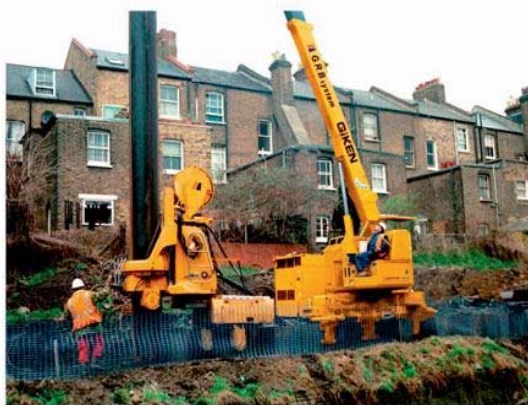
◀ 海外施工現場 (ロンドン)
