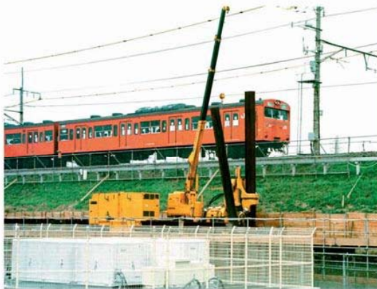
◀ GRBシステム (近接絶対安全工法)
