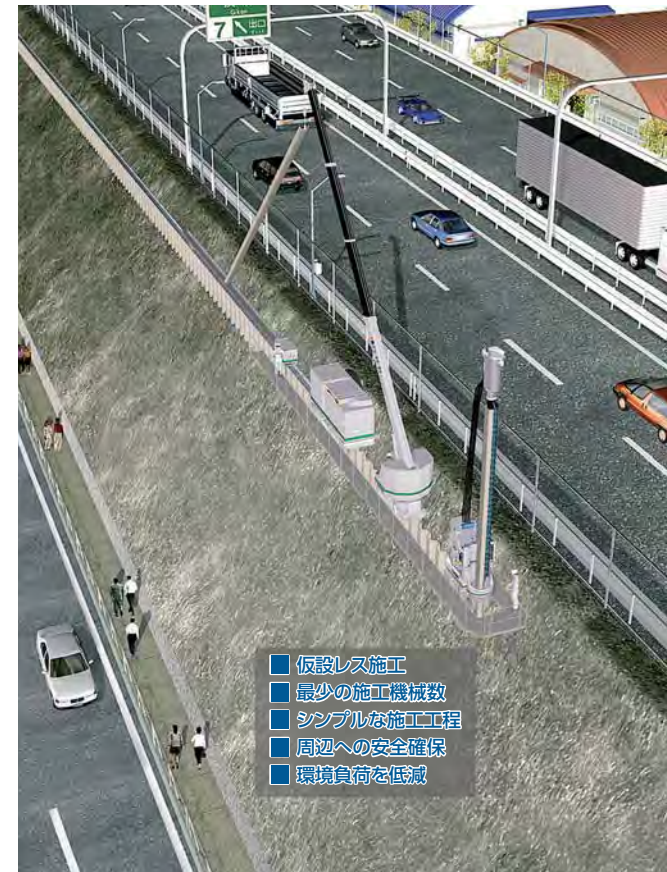
硬質地盤クリア工法の適用例
