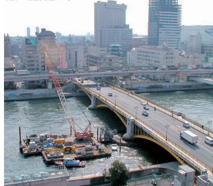
橋脚基礎耐震補強工事
