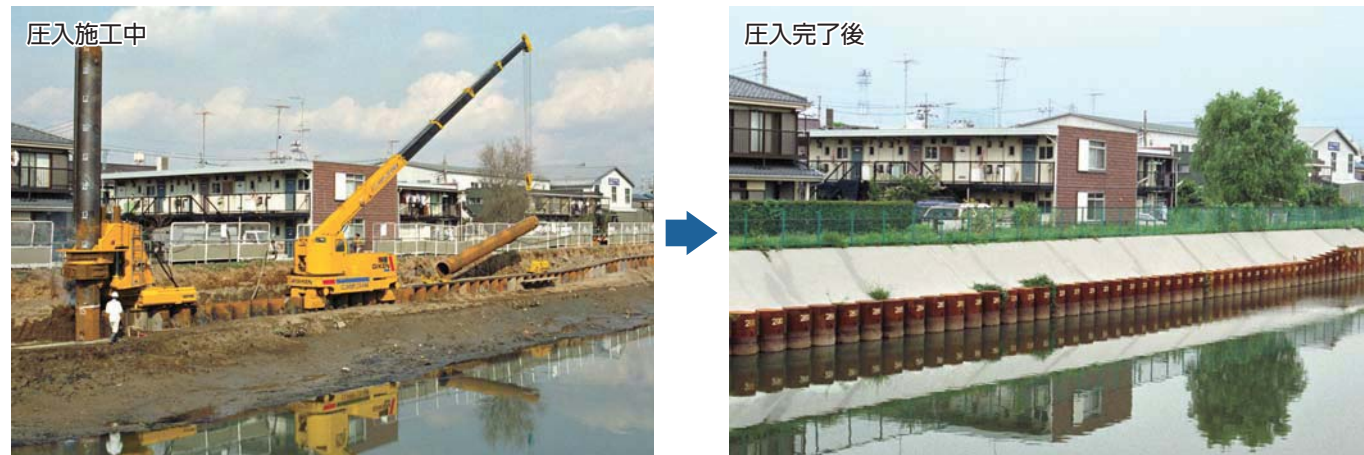
地球と杭が一体となったインプラント構造の護岸を仮設レス施工で構築
